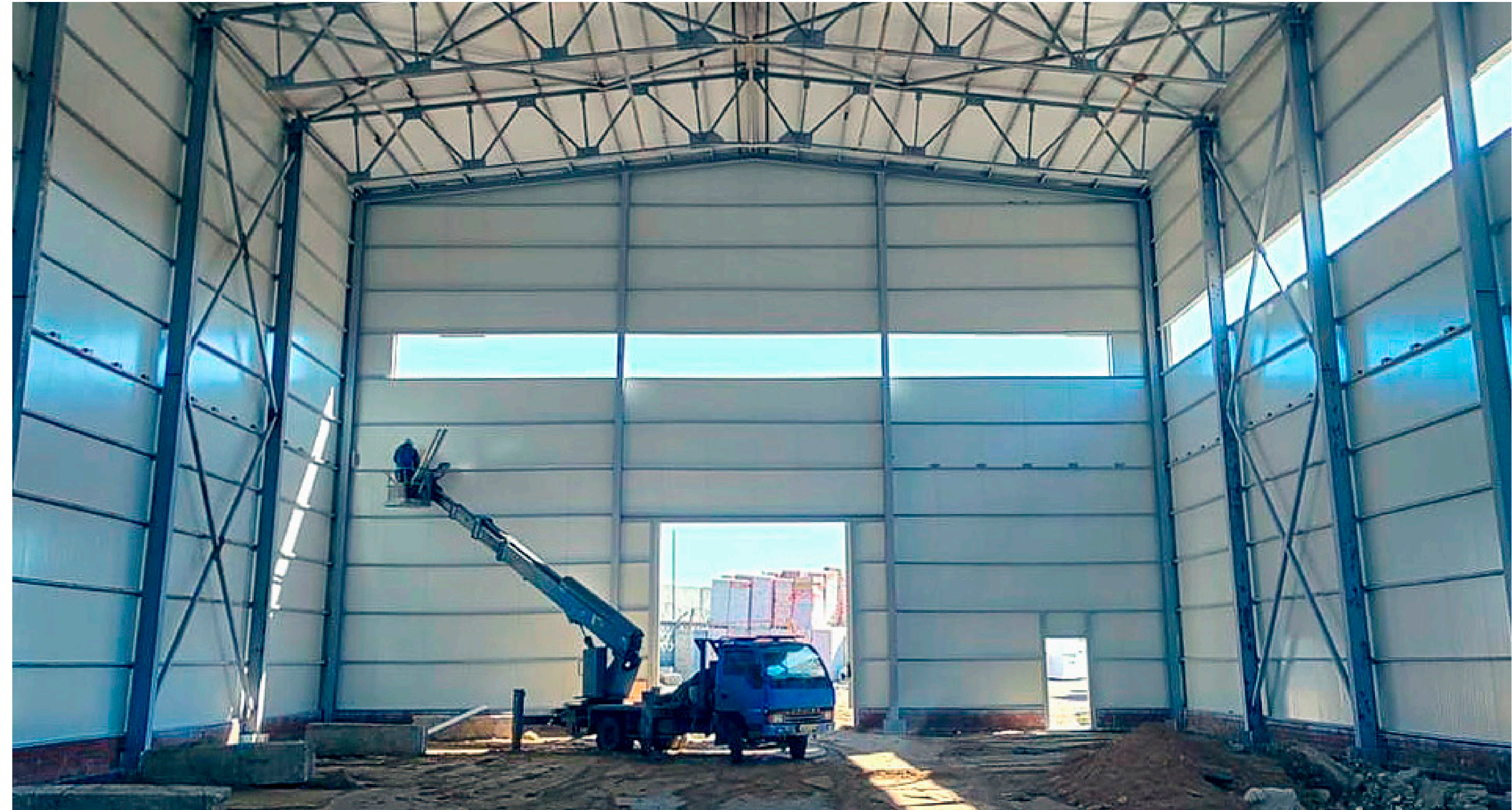
ООО «АВТОАЛЪЯНС», процесс возведения
