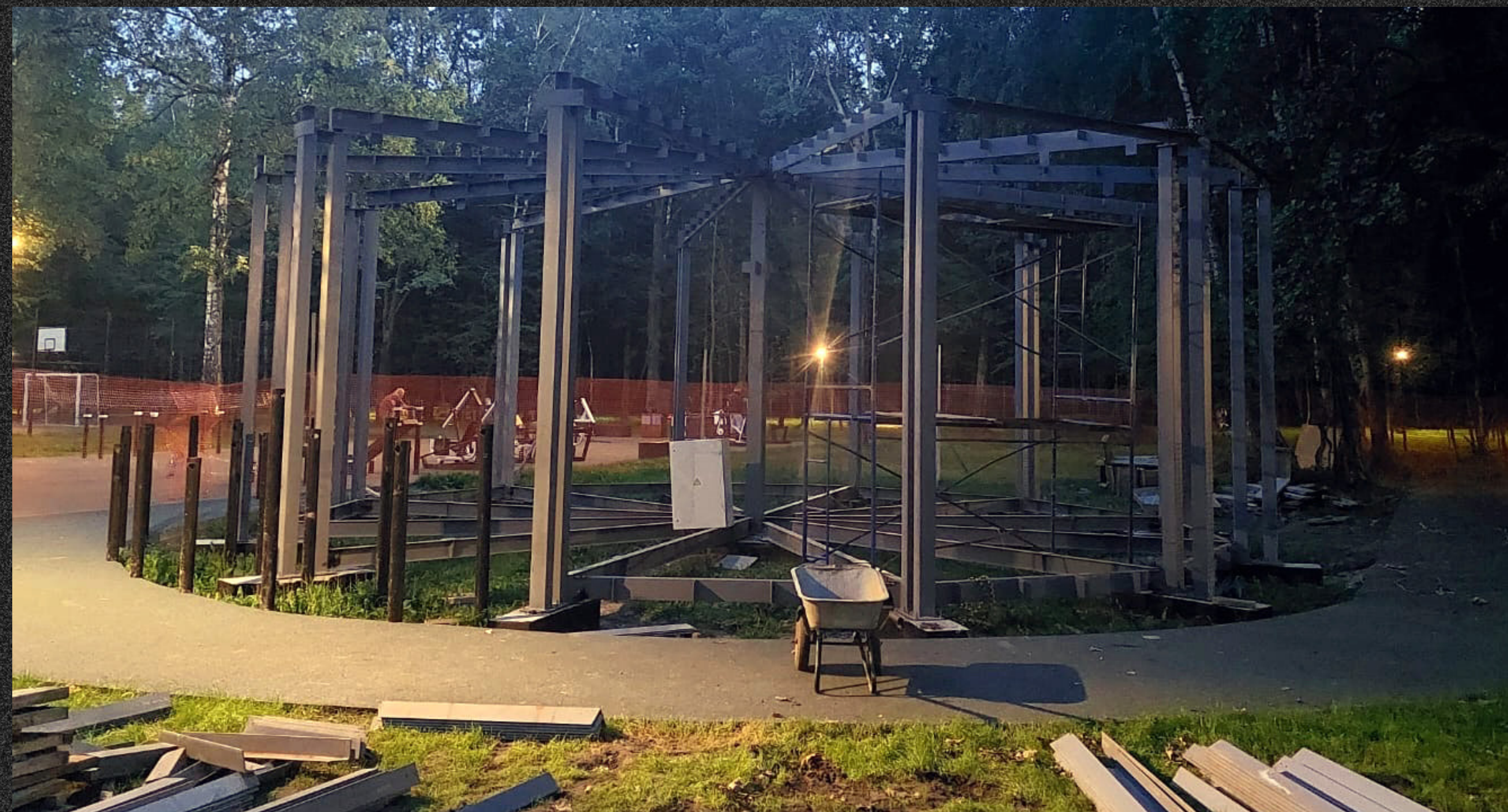
Парк Островского, процесс возведения
